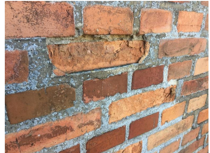
Eksempel på frostsprængning af lavtbrændte røde maskinsten.
